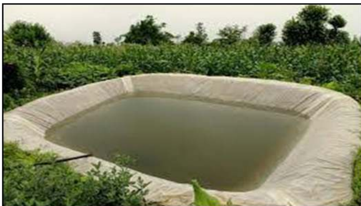
شکل ۲- سیستم جمع‌آوری آب باران و نحوه‌ی استفاده از آن در مقیاس کوچک (اسلامیان و همکاران، ۱۳۹۴)
