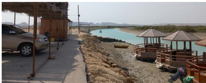
شکل ۱۲- اسکله تفریحی دهخدا
